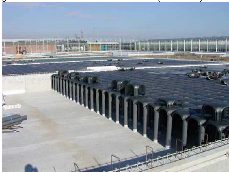
Figuur 6 Plaatsen van Watershell cassettes in een betonbak (Bron: www.waterblock.nl )
